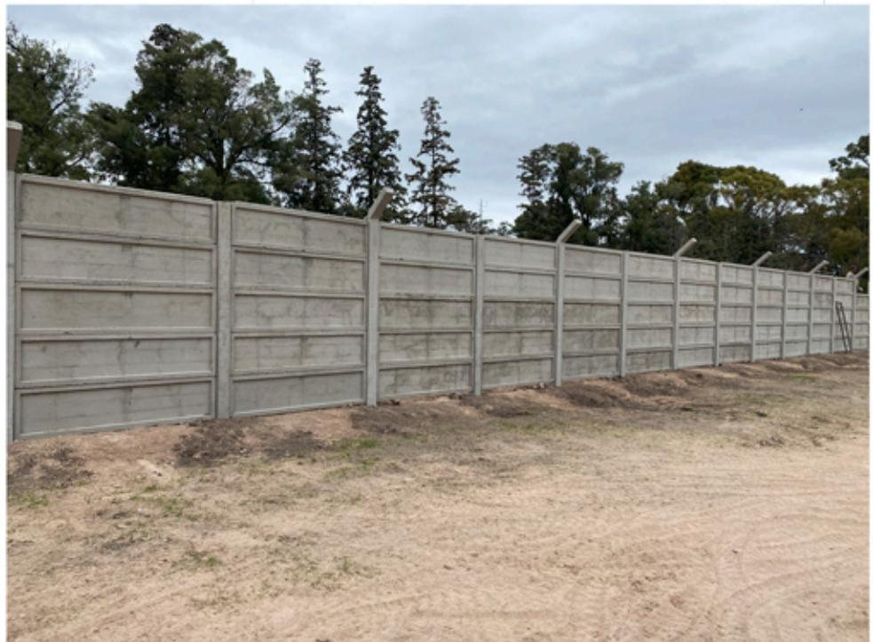
Placa de hormigón premoldeado para cerco recuperable. Diseñada con armadura de refuerzo. Terminación lisa en una de sus caras y con refuerzo en la cara posterior.
